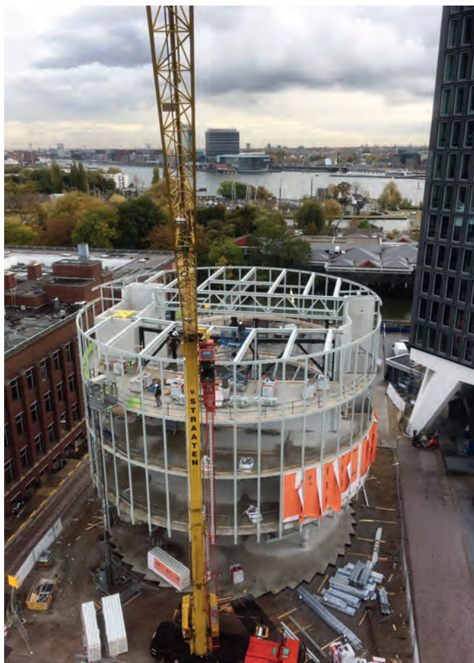
De bovenbouw heeft een dragende staalconstructie die afsteunt op de betonnen tafel van de tweede verdiepingvloer. (Foto: Buiting Staalbouw)
