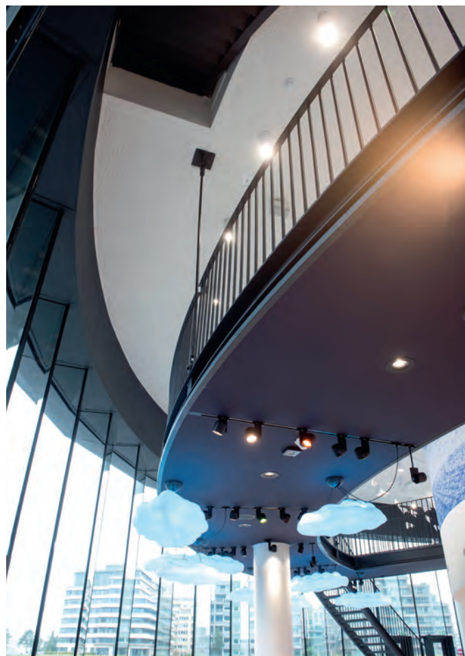
De eerste verdieping bestaat uit hangende onderdelen, waaronder een loopbrug.
