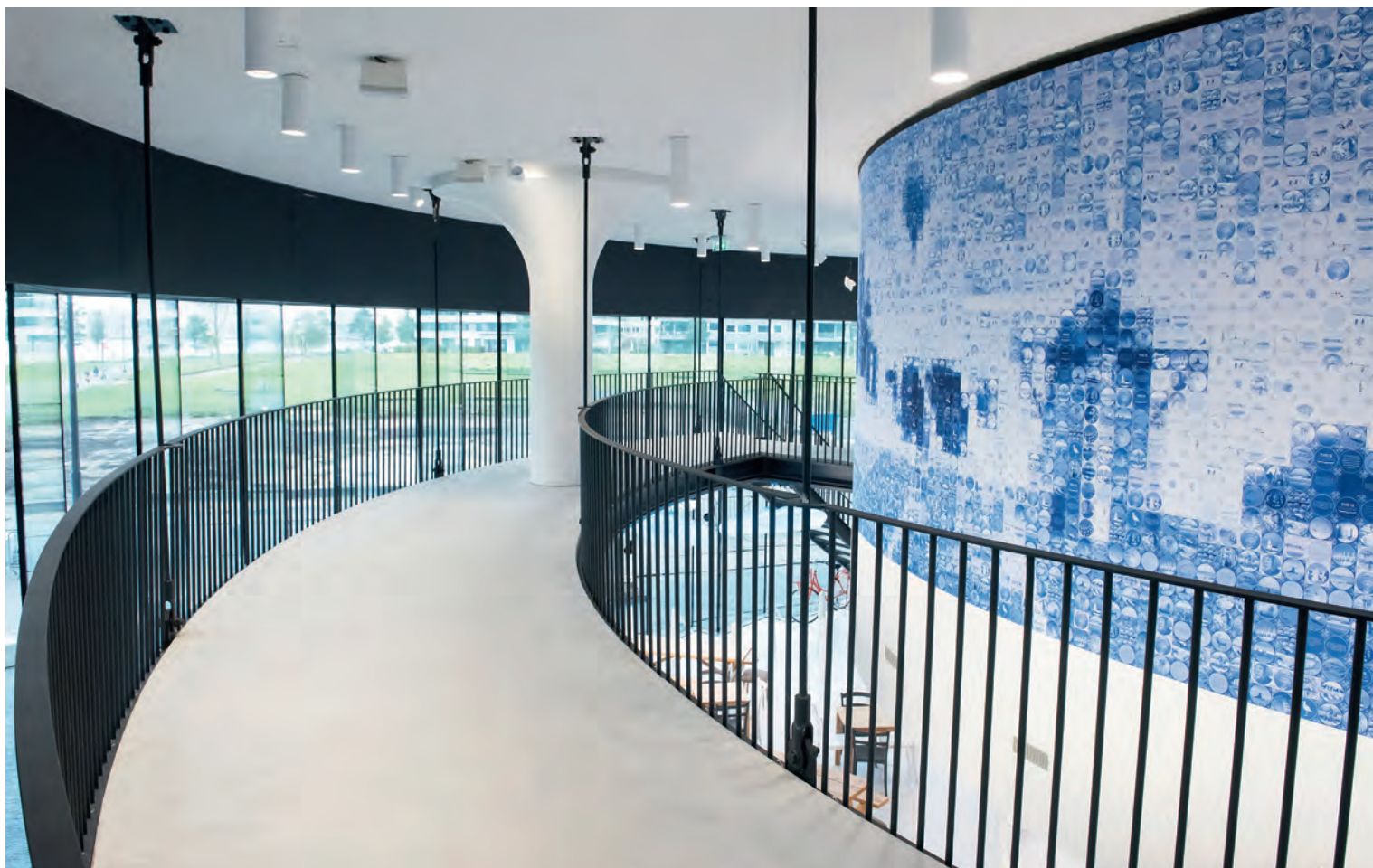
De kolommen steken door de hangende loopbrug heen en fixeren die in horizontale richting.
