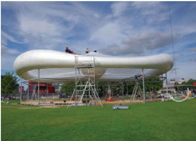
In opdracht van BNP Paribas heeft Buitink Technology – in samenwerking met haar Franse partner Highpoint Structures – een verplaatsbaar, demontabel paviljoen gerealiseerd, WAVE genoemd.
